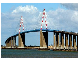
Pont de Saint-Nazaire
